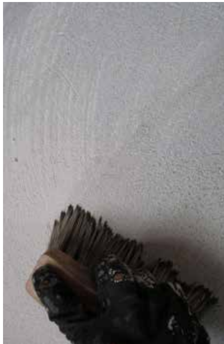
Lasering av murstocken i syfte att få en levade och kontrastrik yta.
