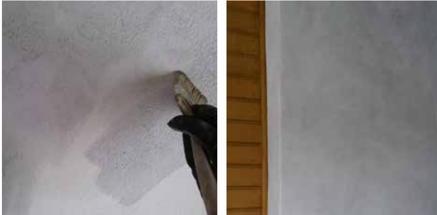
Lasering av murstock i syfte att få en mjuk och levande yta.
